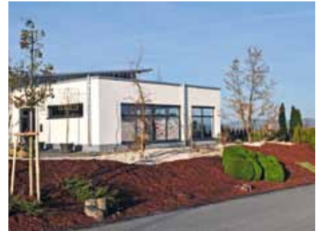
Der neue Anbau wurde im November 2013 fertiggestellt und ergänzt das Fachgeschäft um einen Gastronomiebereich.
